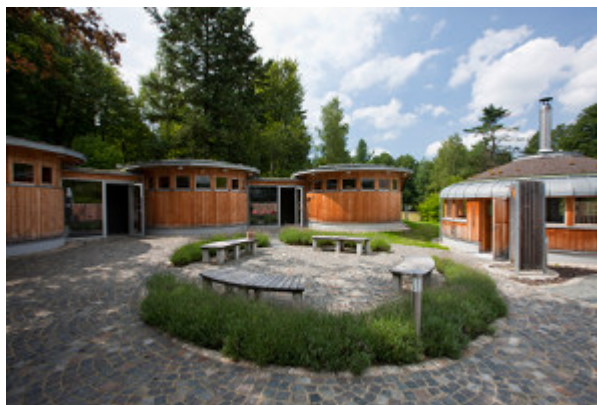
Saunadorf Bad Brambach
