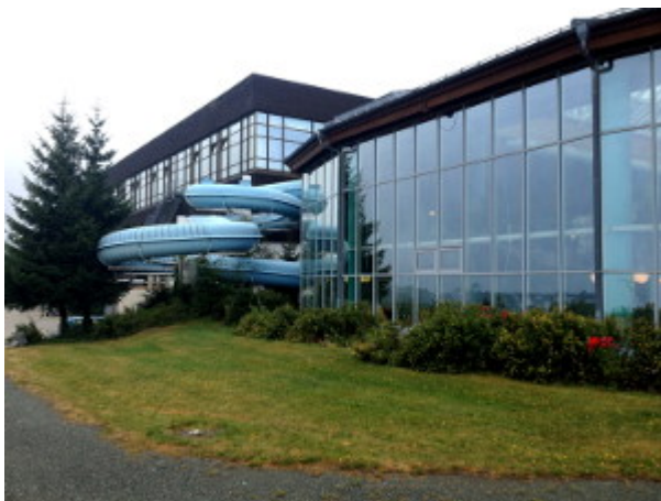
Bad von hinten, außen
