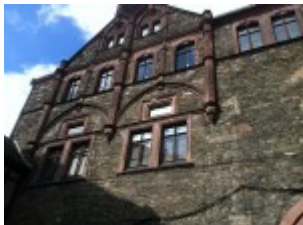
Nahansicht auf die Fenster
