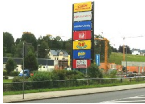
Das neue Göltzschtalzentrum im Bau
