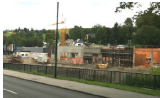
Hier wird kräftig gebaut.
