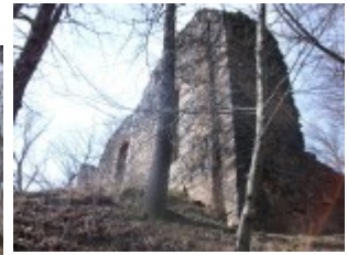
Nur noch das Erdgeschoss ist übrig geblieben.
