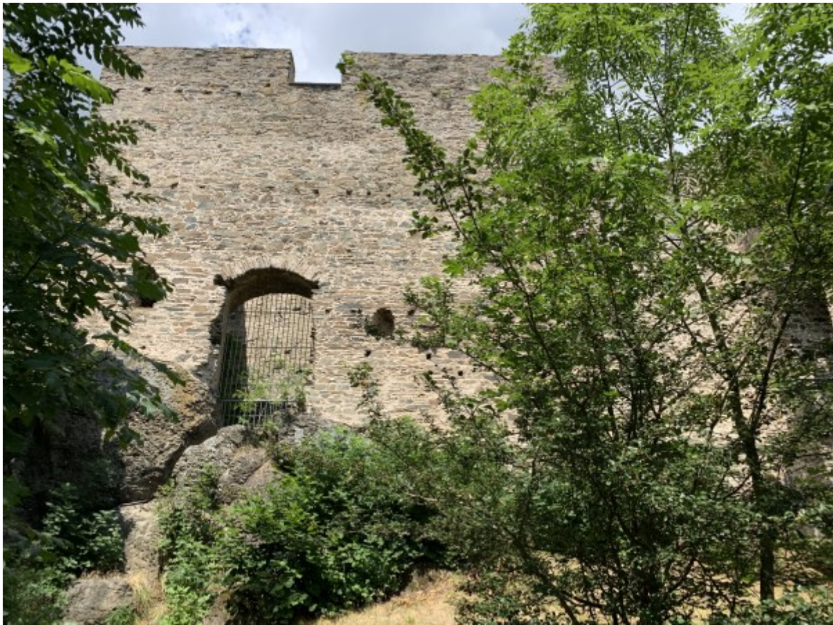
Mauer mit vergittertem Durchgang
