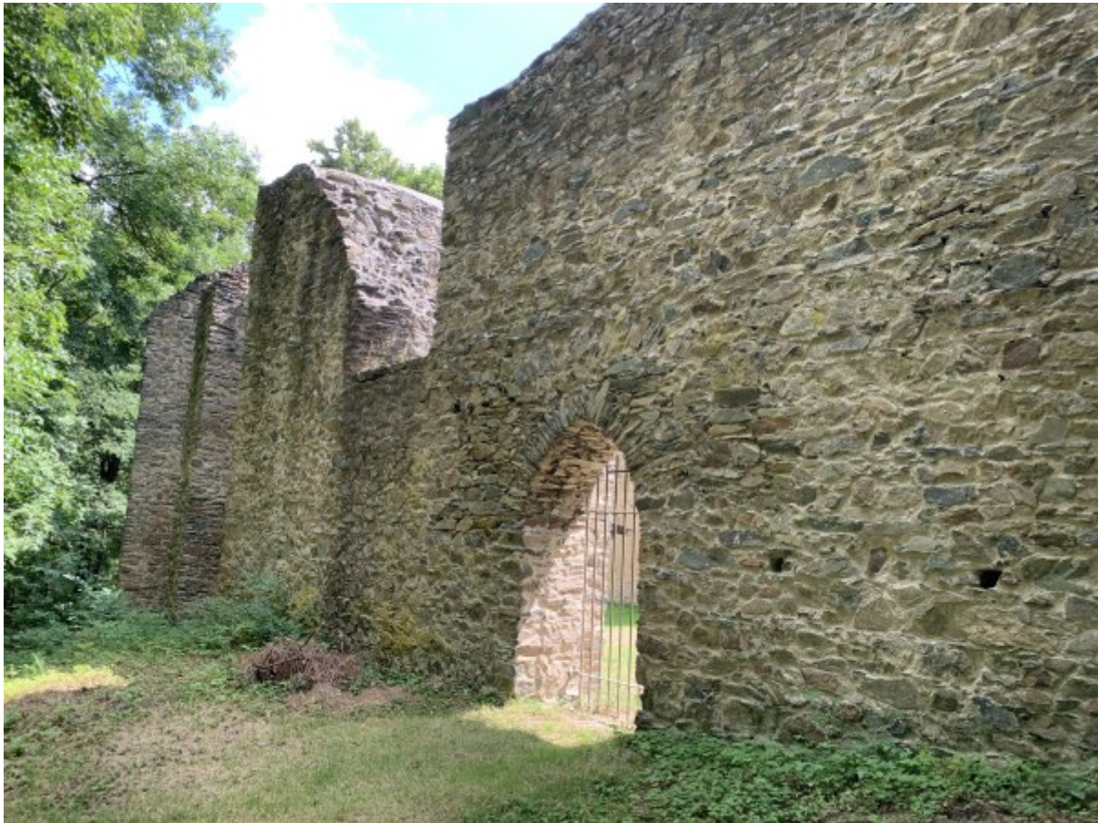
Halbhohe Mauer - Gut zu sehen: die einst großen Fenster
