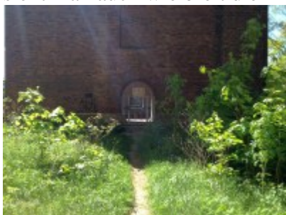
Dort wo es tief nach unten geht sind Absperrungen eingerichtet.
