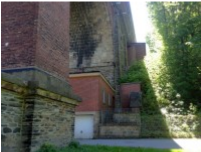
Straße durch den größten unteren Bogen
