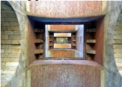
Blick nach oben innerhalb eines Torbogens
