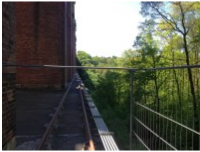
Schiene für Wartungsarbeiten auf mittlerer Höhe
