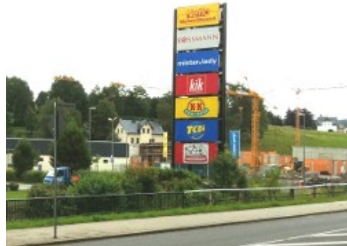
Das neue Göltzschtalzentrum im Bau
