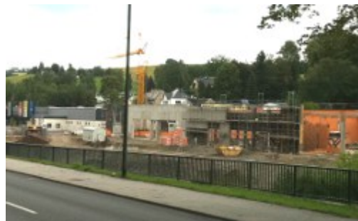
Hier wird kräftig gebaut.
