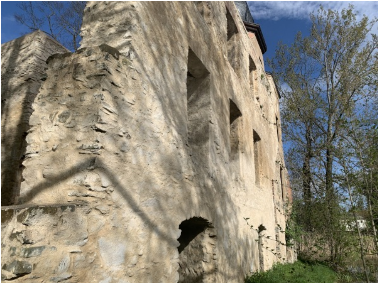
Außenwand des Schlosses: Das Bauwerk strotzt immernoch vor Stolz.
